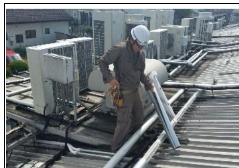
保温工事の様子
