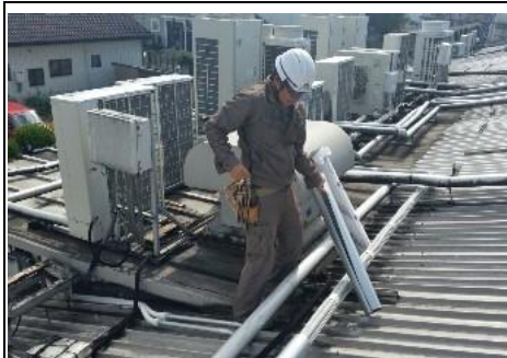
保温工事の様子
