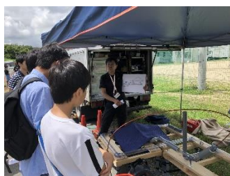
水道工事で行う配管の様子を実演しています。
