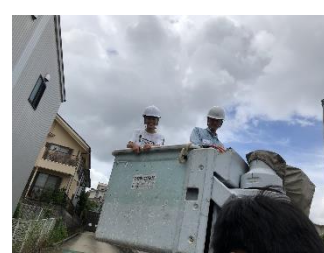
電気工事で使う高所作業車に実際に乗車。
